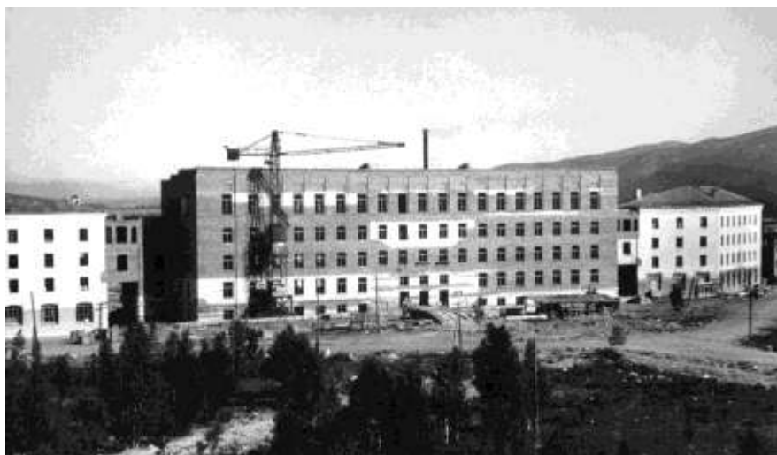
Строительство геологического института. ( Ул. Ферсмана, 14). 1959 г. Фото из архива
